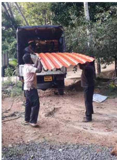
Operai al lavoro per costruire la copertura del tetto della scuola dell'infanzia di Lihiniyawa.
